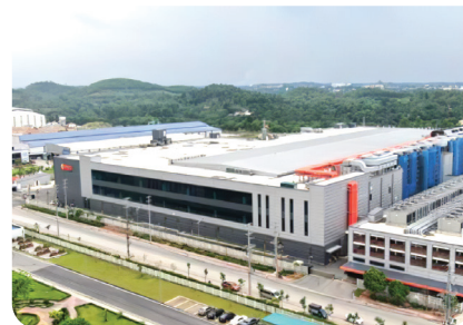
JNTC Phase 3 - Phase 4: Nhà máy 3 & 4 Công ty TNHH JNTC VINA
